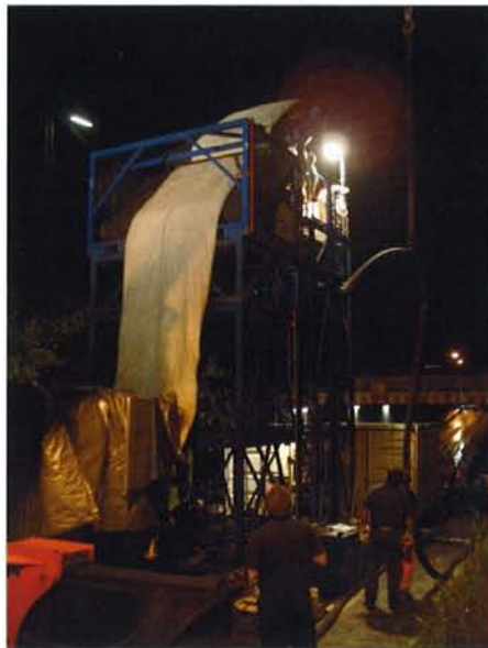
Um die Sperrung der Unterführung zu minimieren, wurde die Nacht durchgearbeitet.
