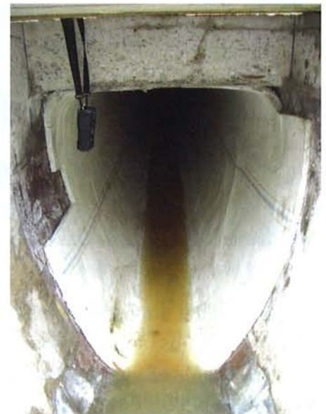
Ungewöhnlicher Querschnitt: Eiprofil „mit Deckel“.
