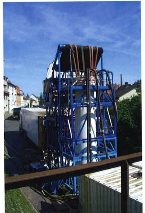
Inversionsturm mit Heizschläuchen während der Härtingsphase.
