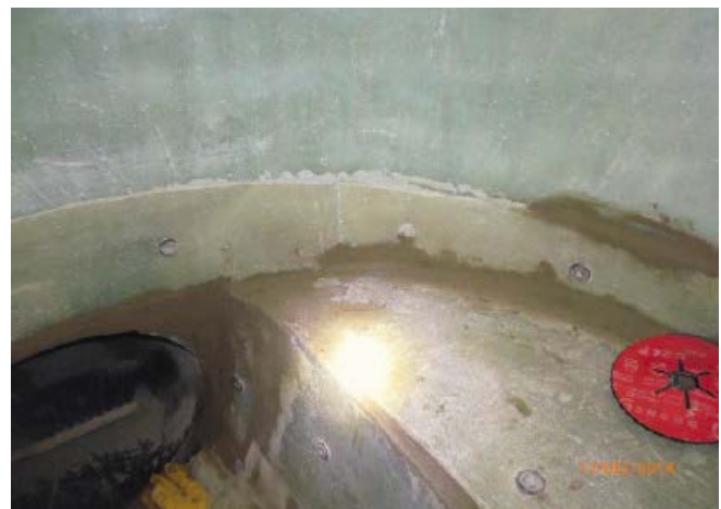
Abb. 3: Schachtunterteil, verankert (Foto: Vertiliner GmbH, Plattling)
